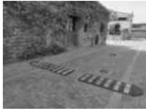
Imatge 48. Modificació del ressalt del carrer de la Creu per a permetre la circulació de bicicletes.
