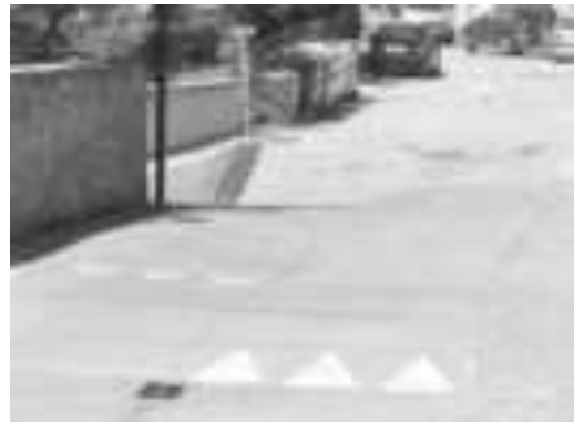
Imatge 38. Plataforma elevada al carrer Major.
