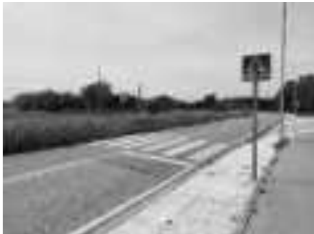
Imatge 4. Pas de vianants amb la senyalització vertical S-13, a la carretera GI-634.
