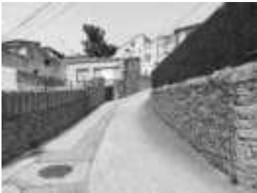
Imatge 41. Plataforma única al carrer Ferreries.
