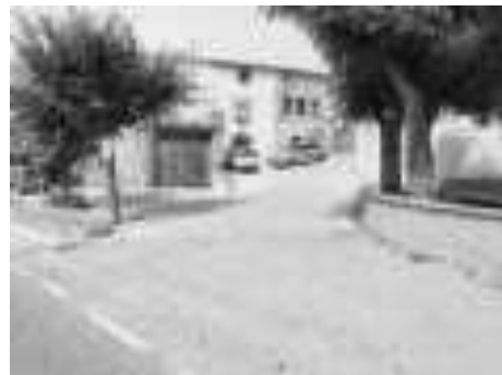
Imatge 9. Incorporació a la GI-634 amb la senyalització horitzontal Stop esborrat.
